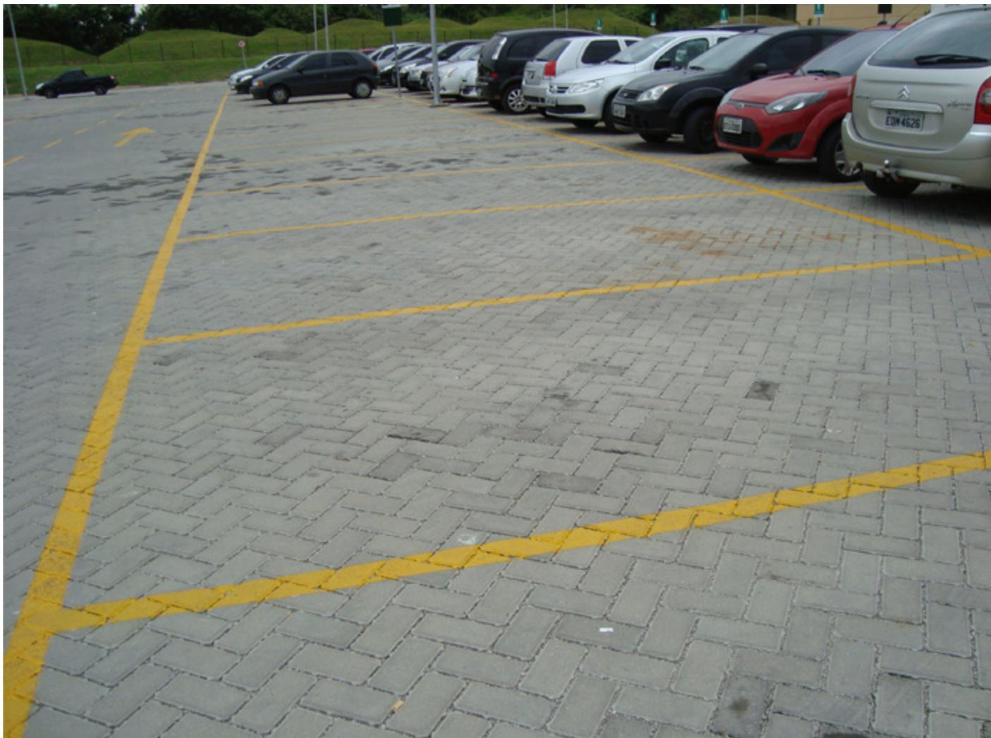
Revestimento composto de peças de concreto para pavimentação. As peças devem atender à ABNT NBR 9781, atentando-se para a dimensão das peças, que para serem consideradas pavimento intertravado devem atender a relação comprimento/espessura  $< 4$ .
